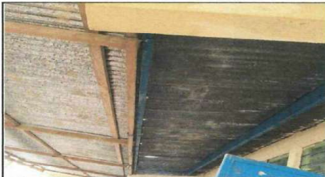
Foto 3: imagen de la parte de abajo y cosntaneras del corredor en donde se ha priorizzato la sustitucion po cosntaneras de metal. E imagen de la parte forntal de abajo del techo en donde se observa perforaciones y
